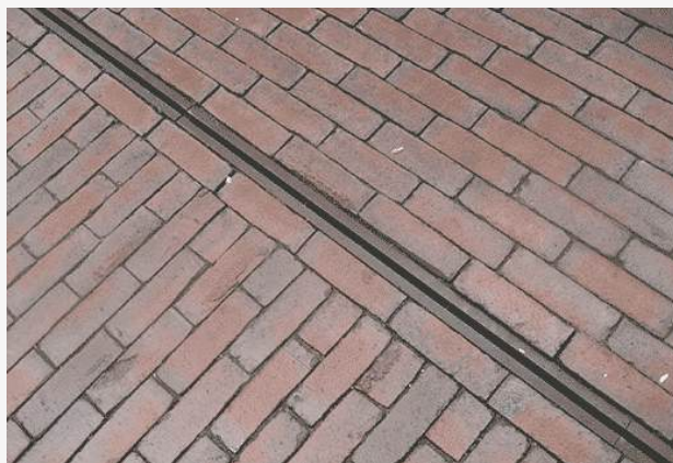
Sleufgoot Metal Steelline 3, cortenstaal.
