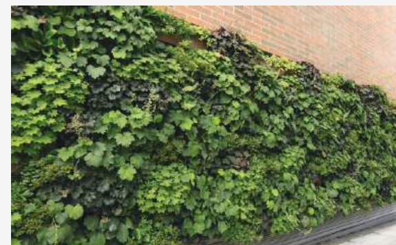
Voorbeeld van een wand met gevelpanelen en vaste planten
